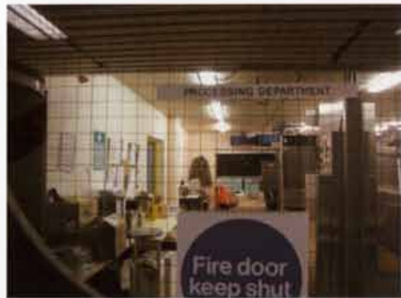
火災が起きると遮断され、延焼を防ぐために酸素が抜かれるシステムを採用している英国映画協会
