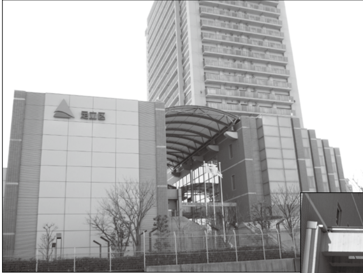
荒川側から見た建物全景
